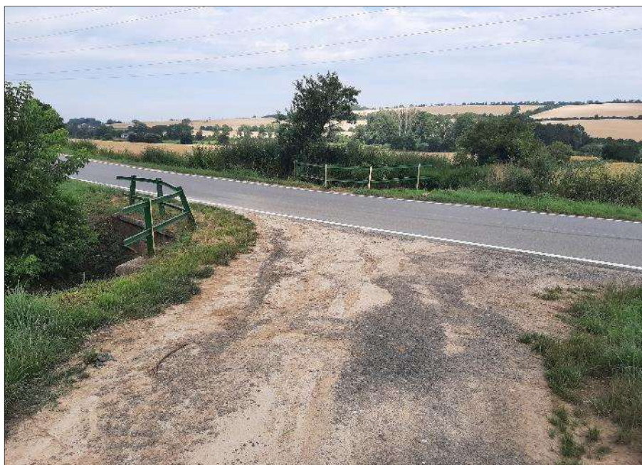
Obr. 11: Ostatní vodní linie „Obůrka“, depozity ornice na polní cestě i silnici
