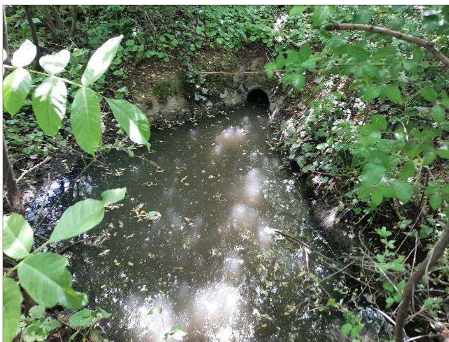
Obr. 14: Umělý odvodňovací příkop „Lověšice“, tůňka u silnice I/55
