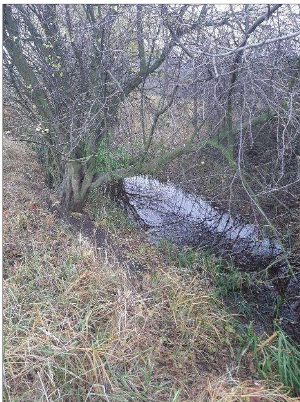
Obr. 36: Voda v otevřené části umělého odvodňovacího příkopu „Záhatí“. Příkop má minimální spád a není zavodněn v celé délce.
